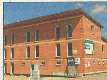
Das dritte GWB-Haus ist fast fertig, mit dem vierten wird in den nächsten Tagen begonnen.
