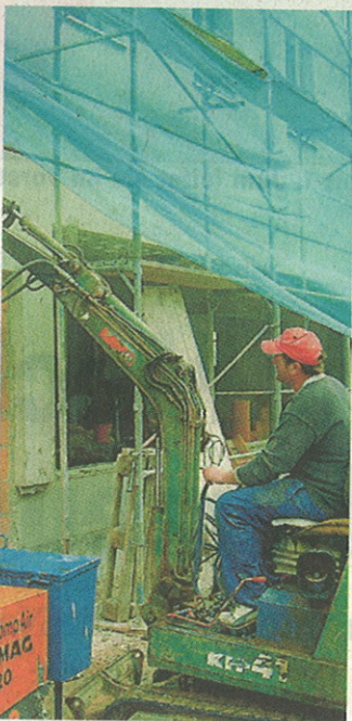
Polier Prokesch bei der Errichtung des Durchganges zu den nordseitigen Parkflächen des neuen Amtsgebäudes.
